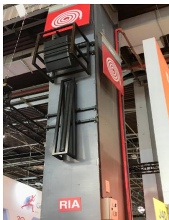
Figure 4 – Haut-parleur sur poteau de la nef à partir de 4m du sol
